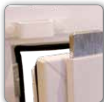
Verriegelungsmechanismus des Fensters, oberes Gegenstück
